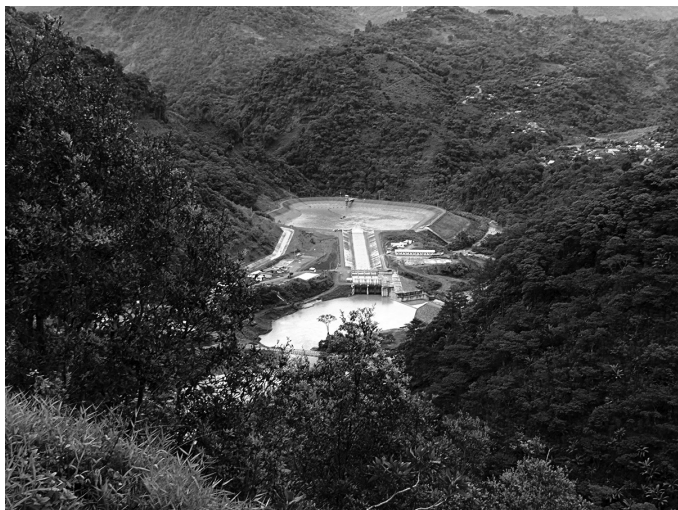
Hidroeléctrica Xacbal en el departamento de Quiché (foto de Giovanni Batz, 2017).
